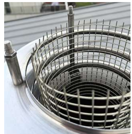
🐦 Protection à grosses mailles contre les oiseaux à l'entrée de la cheminée
