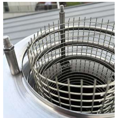
🐦 Grobmaschiger Vogelschutz bei der Kaminmündung
