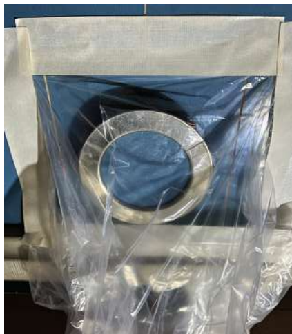
🐦 Abkleben mit durchsichtigem Plastiksack
