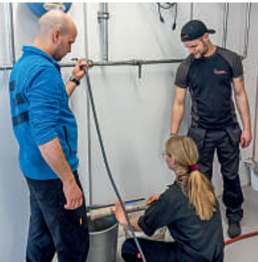
Purge et remplissage d'un système de chauffage.
