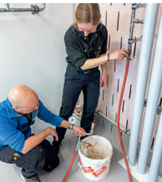
Prova di tenuta e controllo del funzionamento.
