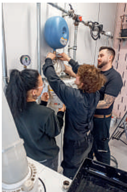
Expansionsgefäss wechseln.
