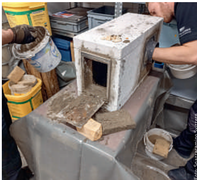
Costruzione di stufe: verniciatura e installazione delle porte del camino.
