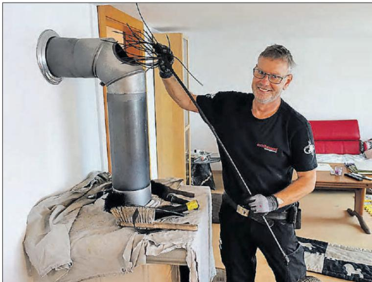
Das Steckrutensystem aus flexiblen und bruchsicheren Nylonstangen ist mit einem Akkubohrmaschinenantrieb bei der Reinigung von verwinkelten Innenrohren sehr effizient.
