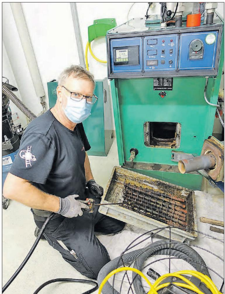
André Bossard reinigt die Regulatoren einer Ölheizung mit einer alkalischen Lösung.
